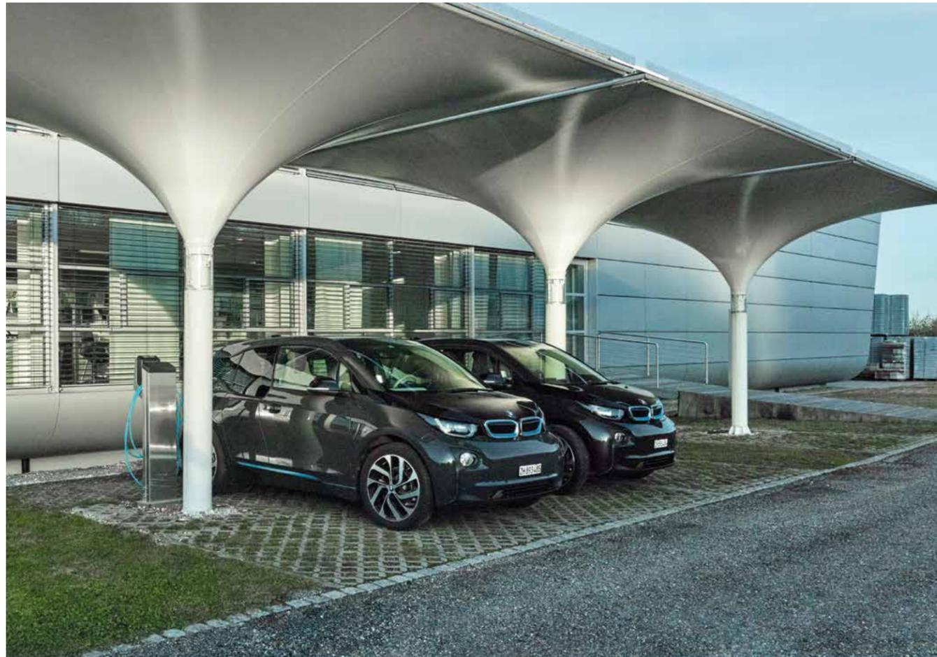
**DEUTSCH** Der Solar Carport ist eine Erfindung, um Elektrofahrzeuge für ihren Ladevorgang zu bedienen. Als Solardach erntet es nicht nur erneuerbare Energien, sondern spendet auch Schatten und Komfort für die Autos, die darunter parken. Das Design des Solar Carports wurde weiterentwickelt aus der klassischen Tulpenform, für die MDT-tex bekannt ist. Ein Solar Carport kann genügend erneuerbare Energie gewinnen, um zwei Elektrofahrzeuge für einen durchschnittlichen Verbrauch zu laden.
